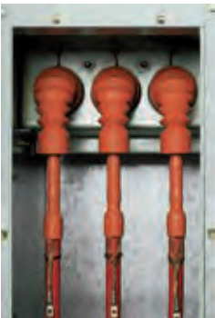
TFTI和RCAB的配套安装
