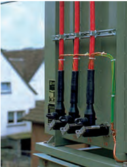
肘型端头用于户外SF 6 变压器
